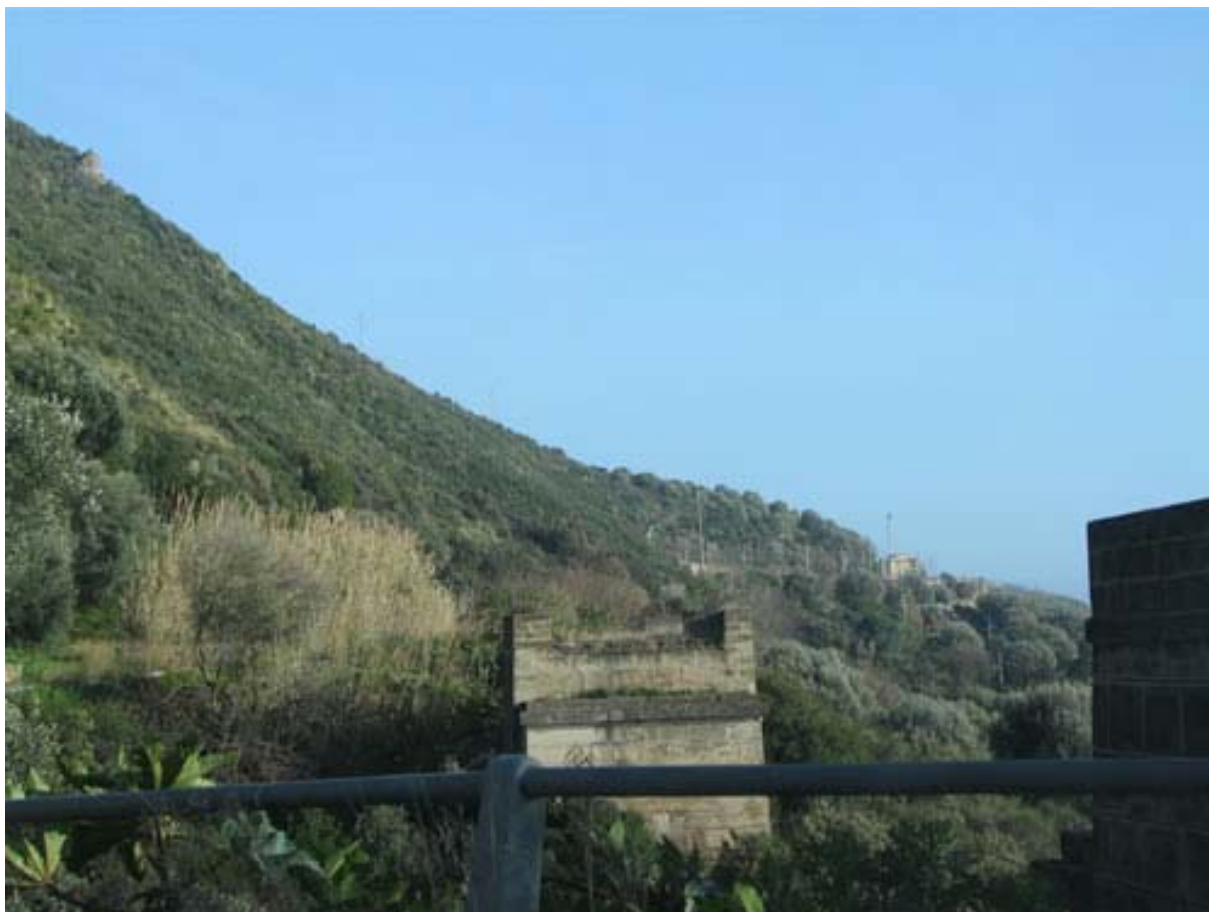
Fig. 1 – Pile in muratura dell'ex-viadotto in ferro ad arco superiore rovescio di 70 m sul vallone Angiemo.
