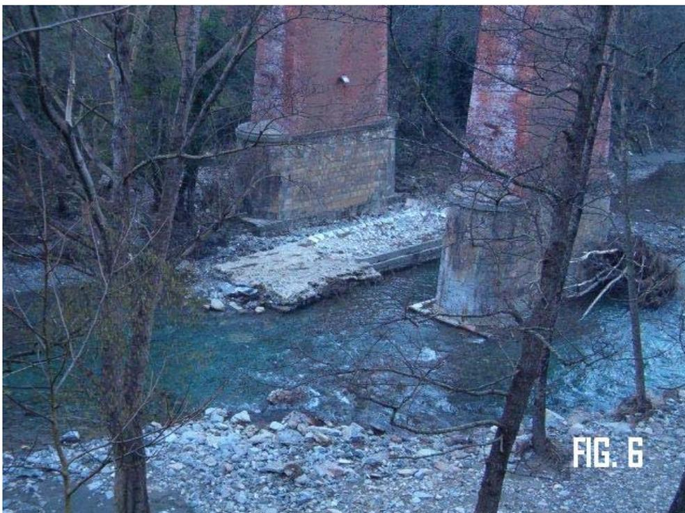
Sfortunatamente gli stessi monconi di pile sul lato Reggio non sono analizzabili in quanto ricoperti da riporti di terra apparentemente artificiali.
