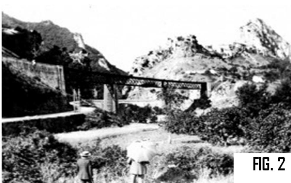
L'angolo di ripresa delle due immagini è abbastanza simile anche se differisce l'altezza di ripresa (la foto di fig. 1 e' stata infatti scattata dal viadotto in c.a. intorno agli anni 70). Appare evidente che il ponte in mattoni utilizza praticamente le stesse spalle di quello in ferro a parte qualche lieve e necessaria modifica.
